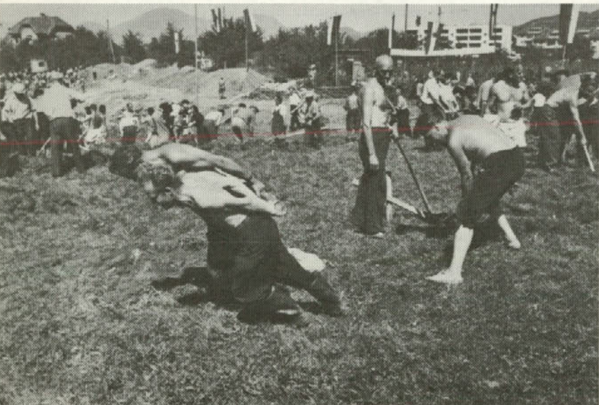
Začetek izgradnje - tisoči rok, tisoči in tisoči udarniških ur...
