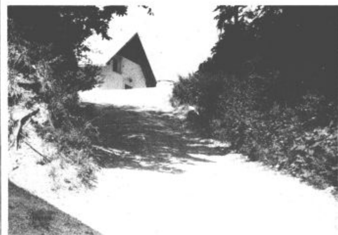
Posledice drsenja zemeljskega plazu v Kavčah so vidne tudi na cestnišču.
