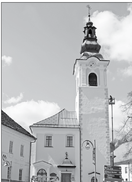
Delavci podjetja Lima vzdrževanje so se lotili temeljitih popravil poškodovanih delov fasade zvonika. (Foto: Benjamin Kanjir)
