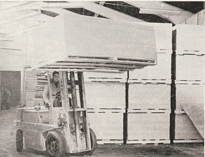
Polno skladišče ognjeodpornih plošč
