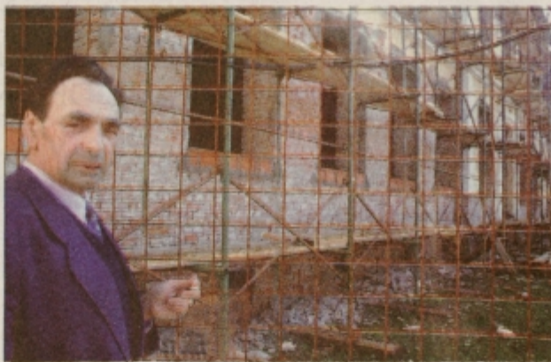
S potekom obnovitvenih del smo zadovoljni in prepričani, da bodo vsi naši občani ponosni na vaški trg, ki se »gradi« obnem z obnovo šole.
