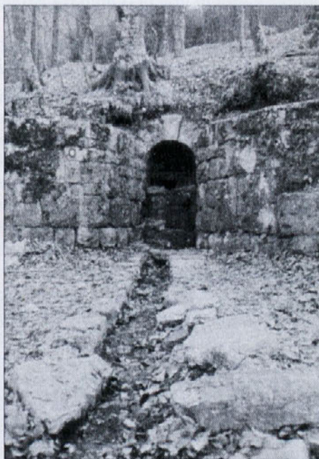
Izvir Gospodična. (Foto: A. Hudoklin, Arhiv ZVNKD Novo mesto)
