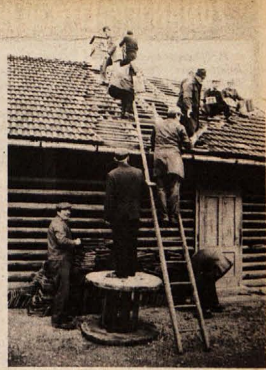
OB JEZERU RIBIŠKI DOM – Ves pretekli teden so kočevski ribiči razdirali in selili brunarico, ki jim jo je odstopilo ZKGP Kočevje. V njej si bodo uredili ribiški dom. Prav te dni si dom že postavljajo pri novem rudniškem jezeru. Delo opravljajo ribiči sami. (Foto: Primc)
