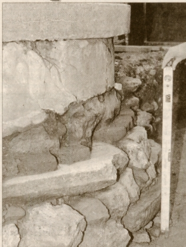
Delno odkopan vodnjak na južni strani dvorišča. V pisnih virih se omenja že v 13. stoletju. Na osnovno gradnjo iz blokov peščenca je bila ob nasutju terena dodana betonska krona. Foto: Boris Farič
