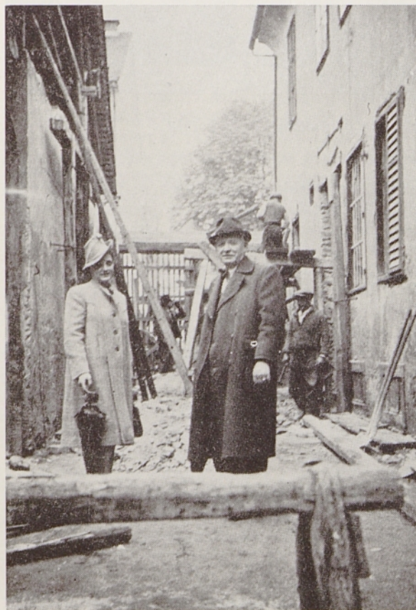
Prezidava mariborskega gledališča l. 1940 (Levo upravno poslopje, desno gledališka zgradba ob Slovenski ulici. Na fotografiji sta igravca Pavel Rasberger in njegova hči Branka)
