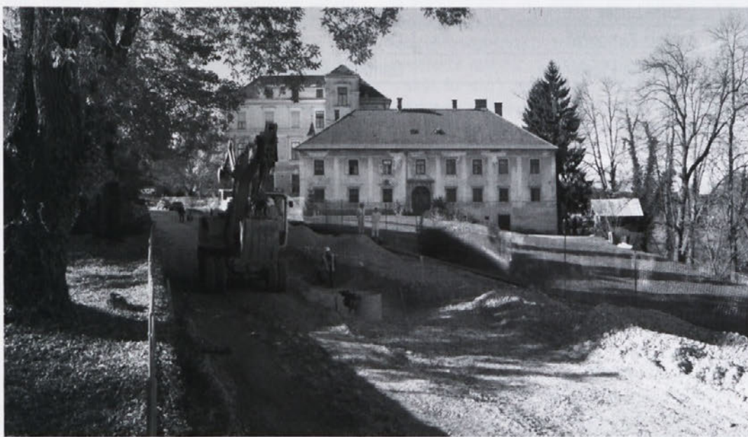
Posseg na Kandijski je nedomišljen, obenem pa je zapečatil usodo območja. Cesta je (oziroma bo) rekonstruirana, pa čeprav ureditveni načrt še vedno ni prinesel jasnega odgovora na dolgoročno ustrezno rešitev te prometnice: ali po bregu Krke ali z vkopom pod gradičem Neuhofof ali pa po obstoječi trasi, le da pod zemljo.
