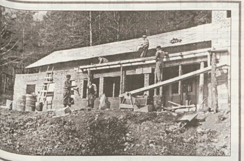
Sviščaki, 1963: najzahtevnejši del razširitve planinske postojanke je bil na prednji strani, kjer je bilo treba razširiti gradbeni teren in dvorišče ter utrditi nasip. (Foto: S. Maraž)
