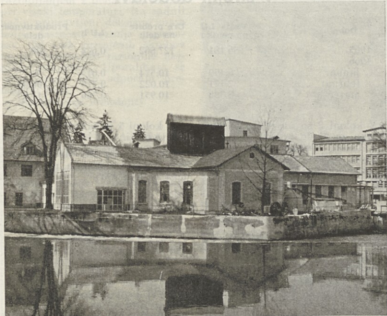
Po rekonstrukciji bo I. papirni stroj precej daljši, zato je bilo treba stavbo »potegniti« prav do Ljubljane. Na sliki levo: Novi podaljšek stavbe (Foto A. V.)
