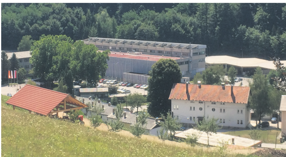
Pogled na radeško papirnico iz bazena, ki za tovarno služi kot požarna voda.
