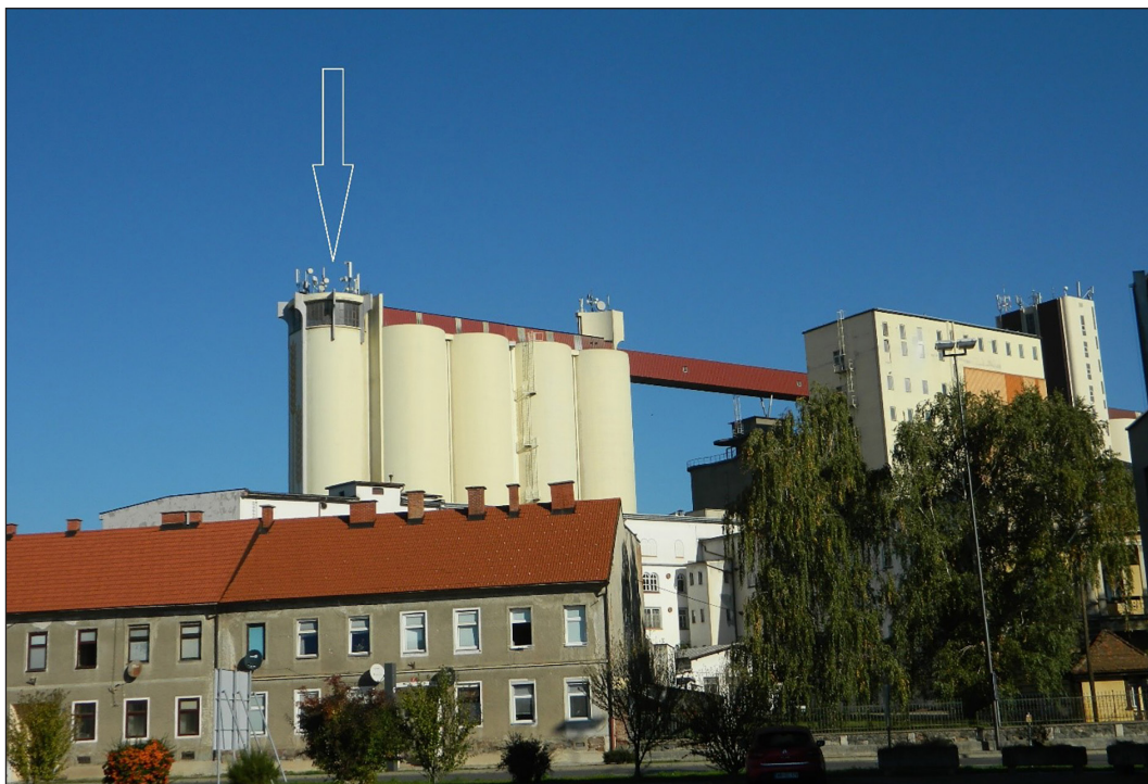
Slika 1: Silosi podjetja Žito d.o.o. v Mariboru. S puščico je označeno gnezdišče sokola selca na vrhu objekta (Foto F. Bračko).
