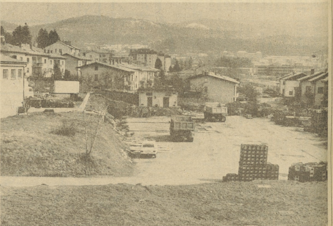
Pogled na dvorišče Mercator-Nanosa v Postojni, kjer so že vidni temelji za postavitev paviljona za prazno embalažo alkoholnih in brezalkoholnih pijač tozda Grosist.
