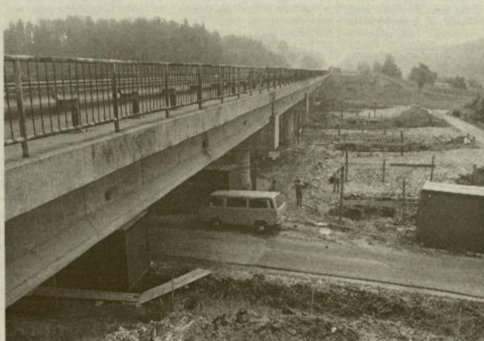
Viadukt Žepina naj bi zgradili do 4. maja prihodnjega leta. Predstavniki podjetja SCT zagotavljajo, da se bodo v celoti držali pogodbenih rokov. Promet s tovornjaki po cesti Žepina-Jarmovec naj bi se tako že ta teden občutno zmanjšal, od konca oktobra, ko naj bi končali postavljanje nosilcev za cesto, pa bodo potrebni le še manjši prevozi.
