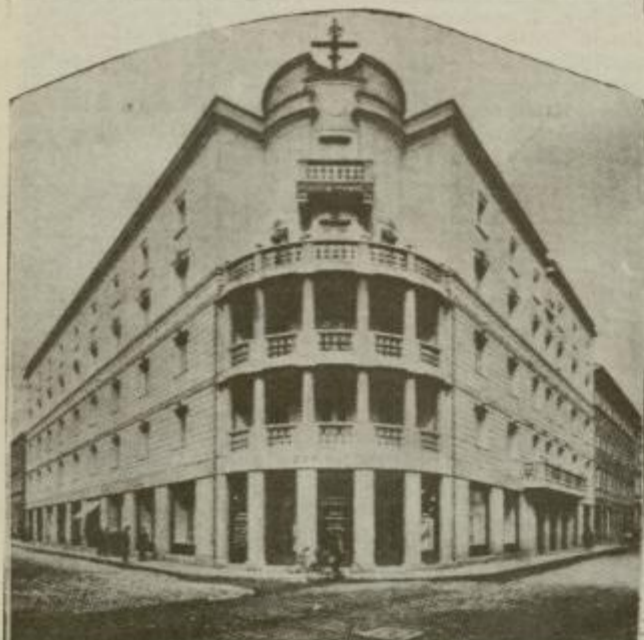
Takšna je bila zgradba na Vodnikovi nekoč, takšna pa bo, ponovno, že oktobra letos.
