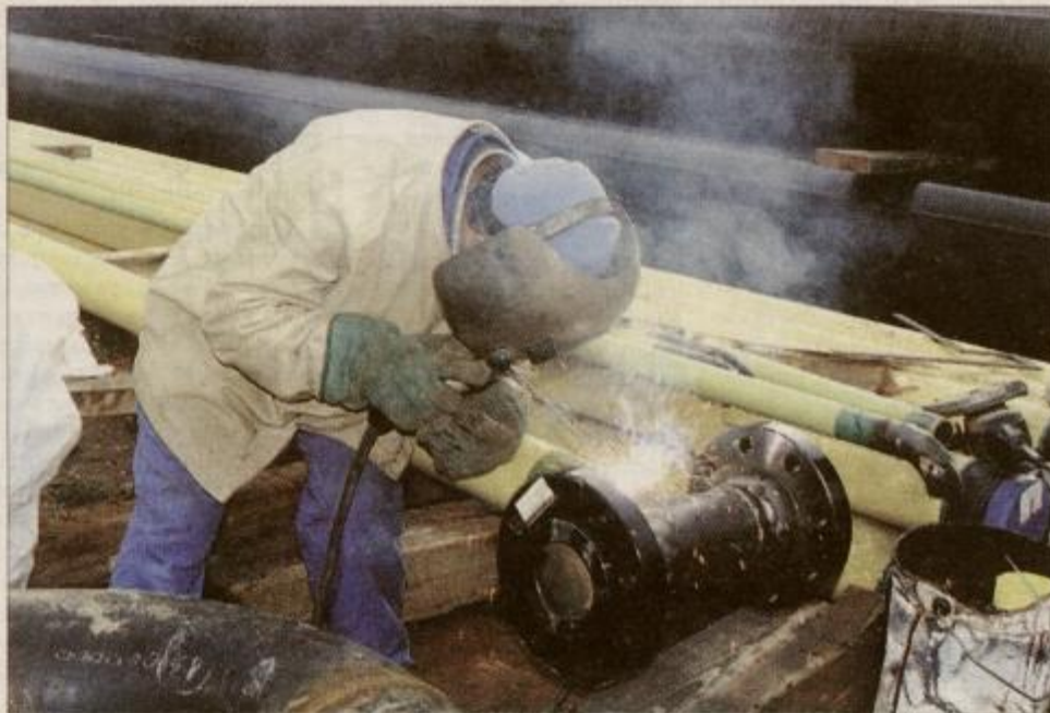
Te dni so začeli že z zaključnimi montažnimi deli. Foto: M. Ozmeč
