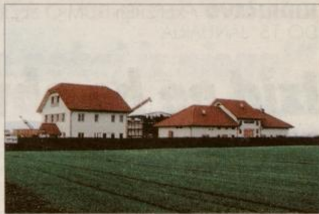
Plinsko kompresorsko postajo so zgradili sredi polja pri Cirkovcah ob cesti Ptuj-Pragersko
