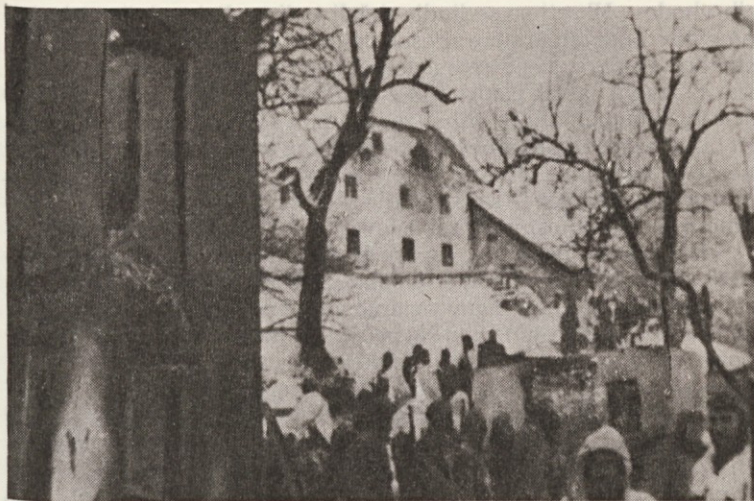
Sl. 27. Požgane Dražgoše. Spredaj na desni je stara Kajžna hiša, na levi nova Kajžna hiša, v ozadju pa Prešnkova domačija in Gobovcova šupa
