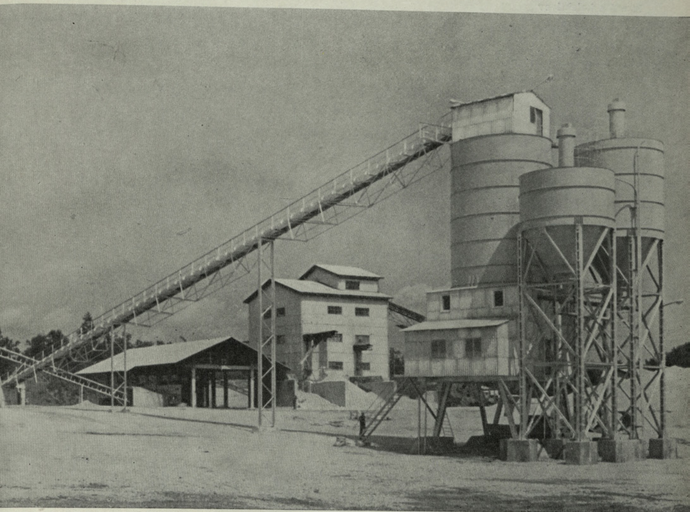
GP »TEHNIKA« LJUBLJANA: NOVA AVTOMATIZIRANA BETONARNA V STOZICAH
