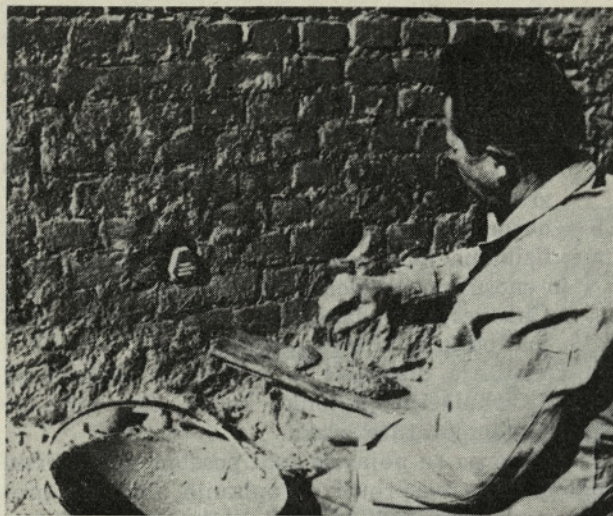
Sl. 6. Vzidavanje elementov RAEM v zid
