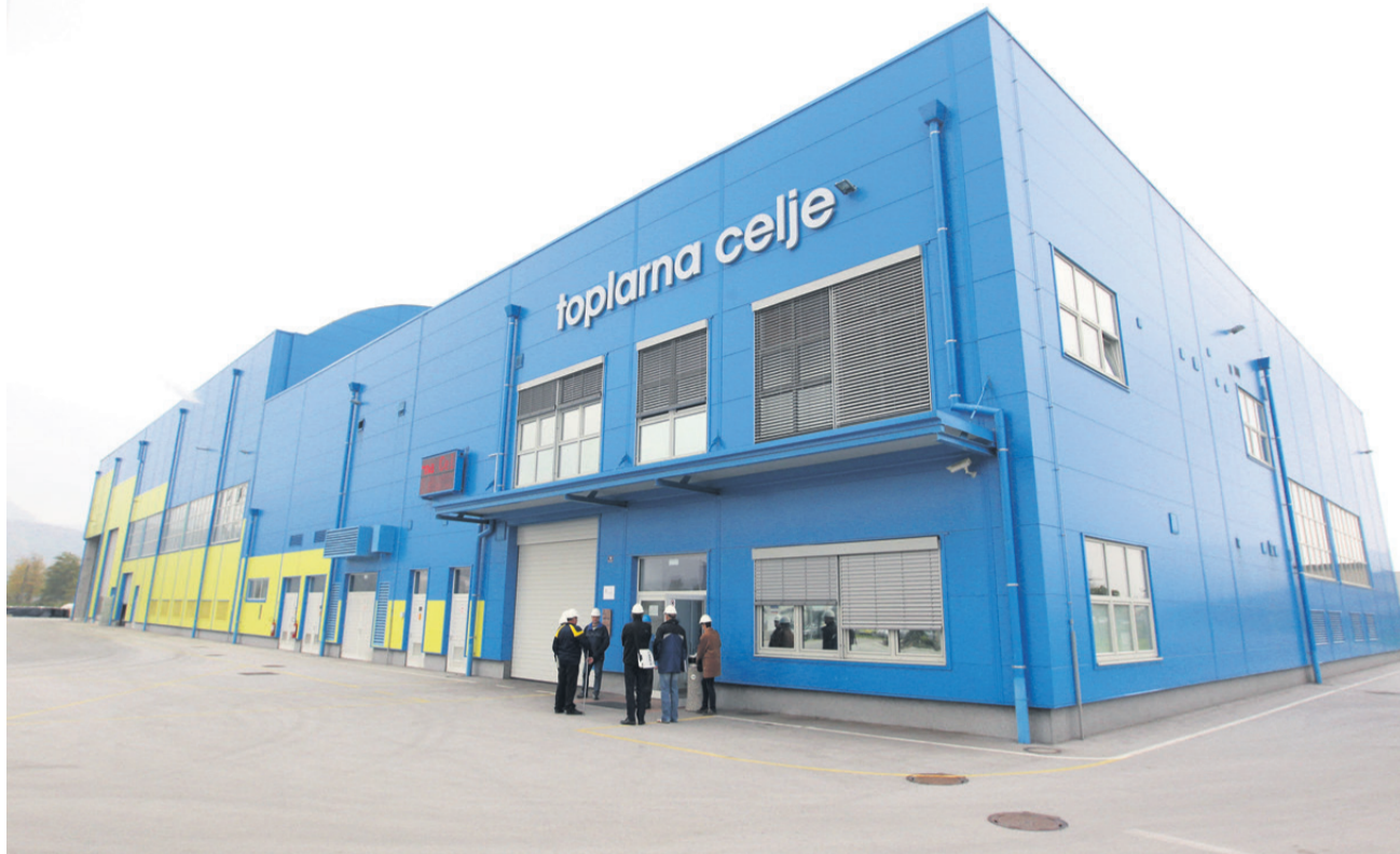
Če v Celju ne bi zgrabili priložnosti, ki se je ponujala po koncu 1. faze gradnje RCERO, toplarna na tem območju ne bi obratovala že od septembra 2010.
