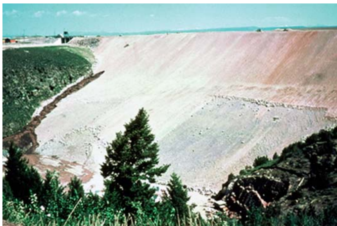
Slika 1 • Porušitev komaj dograjene pregrade »Teton dam«, Idaho, ZDA, leta 1976 (Sylvester, 2008)
