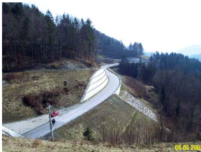
Slika 2 • Izvedbeno zahteven visoki pobočni nasip Orehovica na izstopu iz predora V Zideh ob začetku in po končani gradnji
