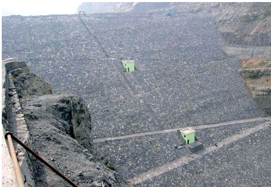
Slika 12 • Nasuta pregrada Shuibuja, Kitajska je visoka 233 m, v peti je široka 616 m (Adam, 2007)
