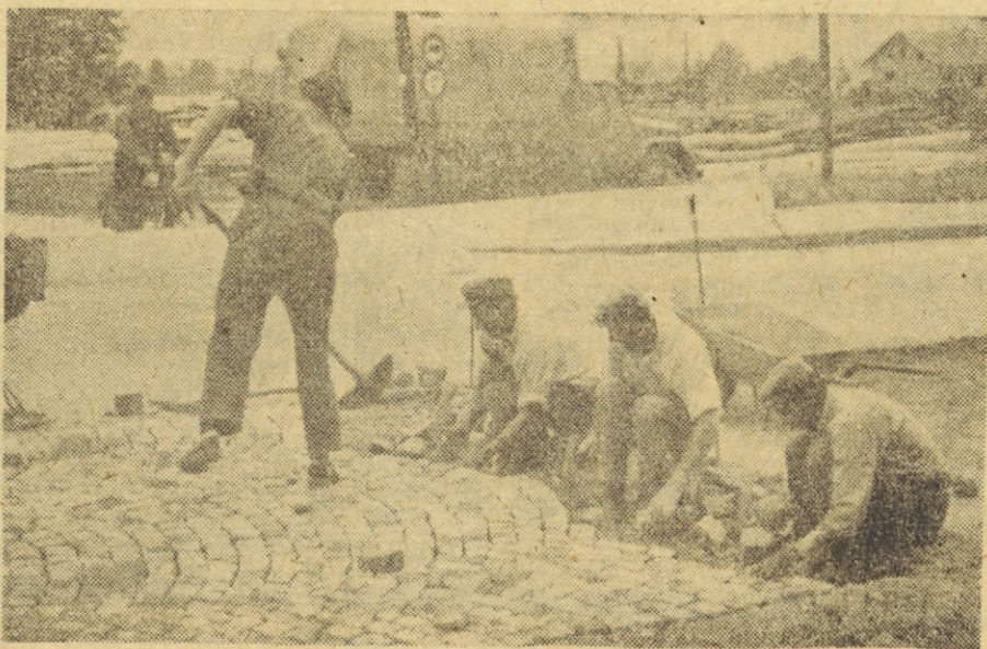
Člani delovne skupnosti Cestnega podjetja popravljajo zimske poškodbe na Dolenjski cesti
