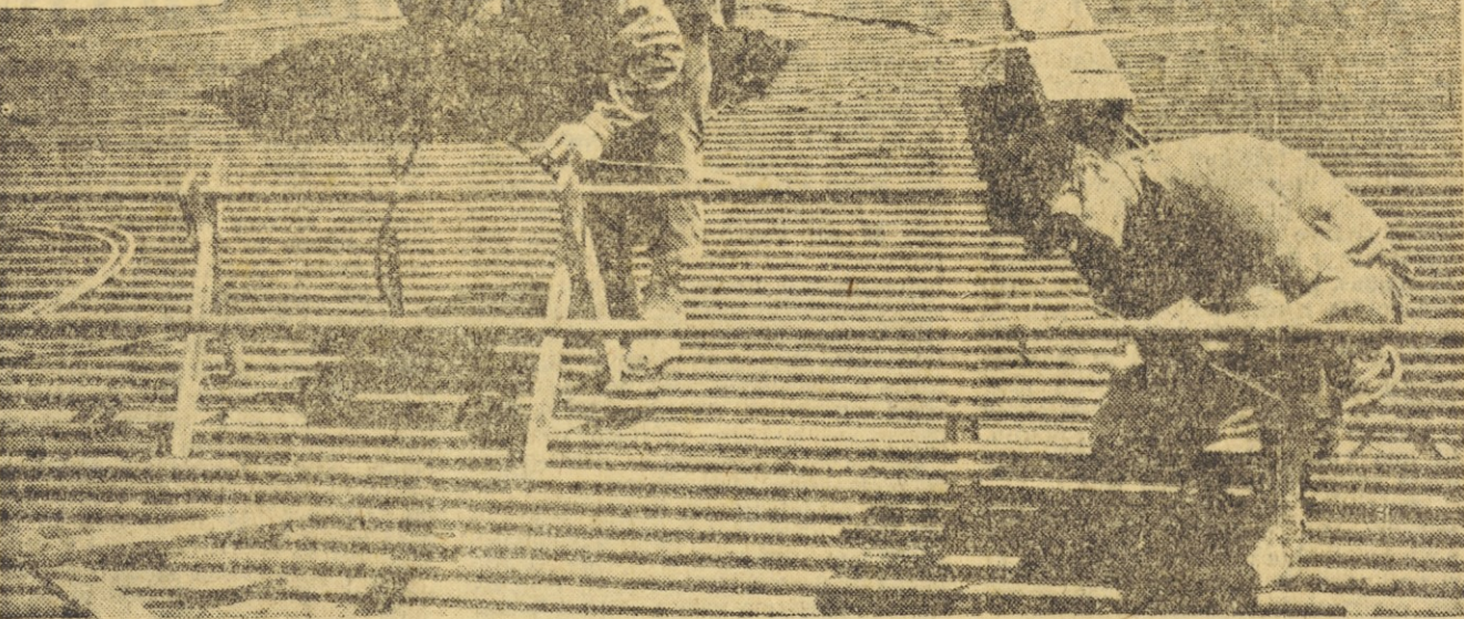
Montaža hladilnih naprav na umetnem drsališču v Ljubljani
