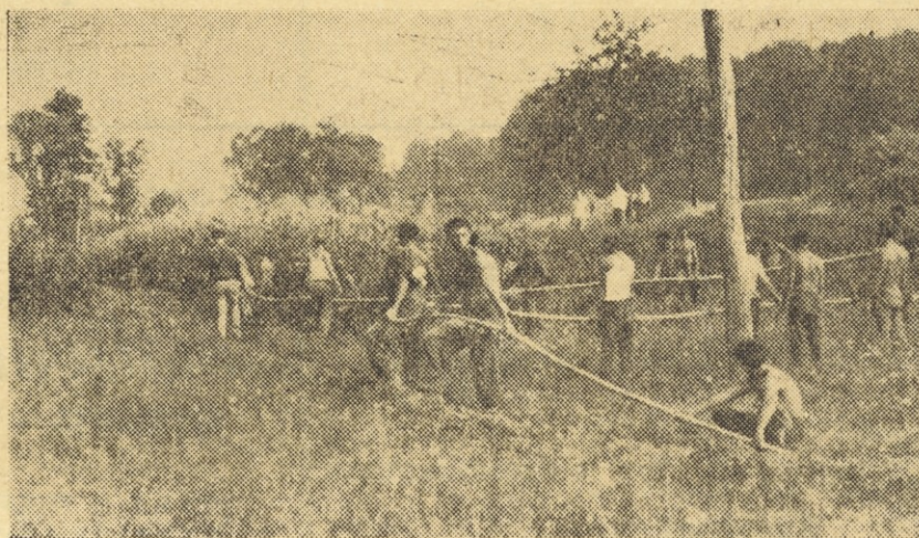
Polaganje medkrajevnega telefonskega kabla
