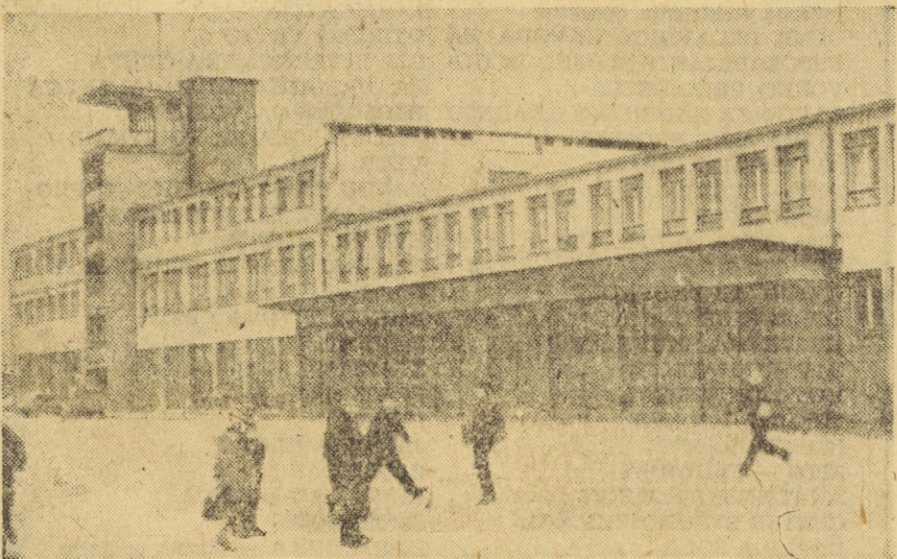
Pogled na nove prostore Poklicne gasilske brigade
