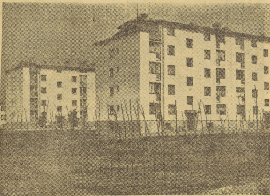
Stanovanjski bloki v Črnučah, ki jih je dogradilo Gradbeno podjetje Črnuče
