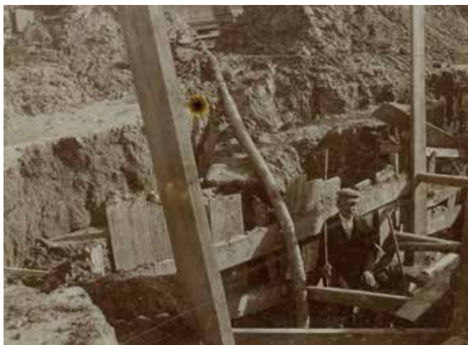
Gradbena jama za novo skladišče Tobačne tovarne v Ljubljani, 1910. (SI_ZAL_LJU/0342, Fototeka A2-056).
