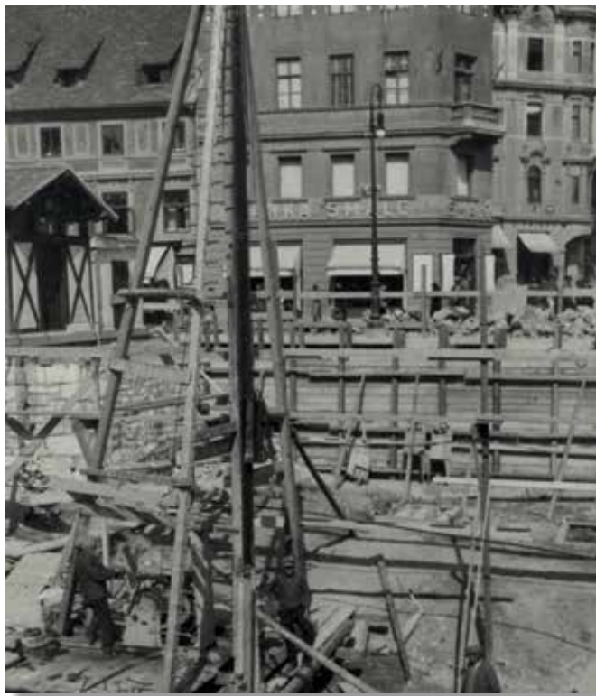
Gradnja Tromostovja v Ljubljani v začetku 30-ih let 20. stoletja, zabijanje pilotov.
