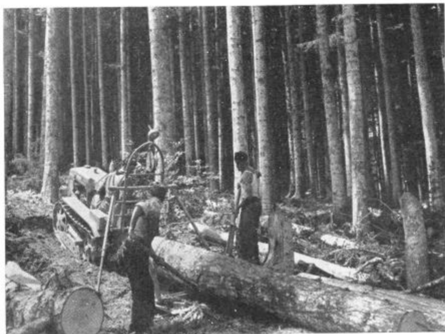
Traktor Fiat C 351 — nakladanje na sankalno ploščo
