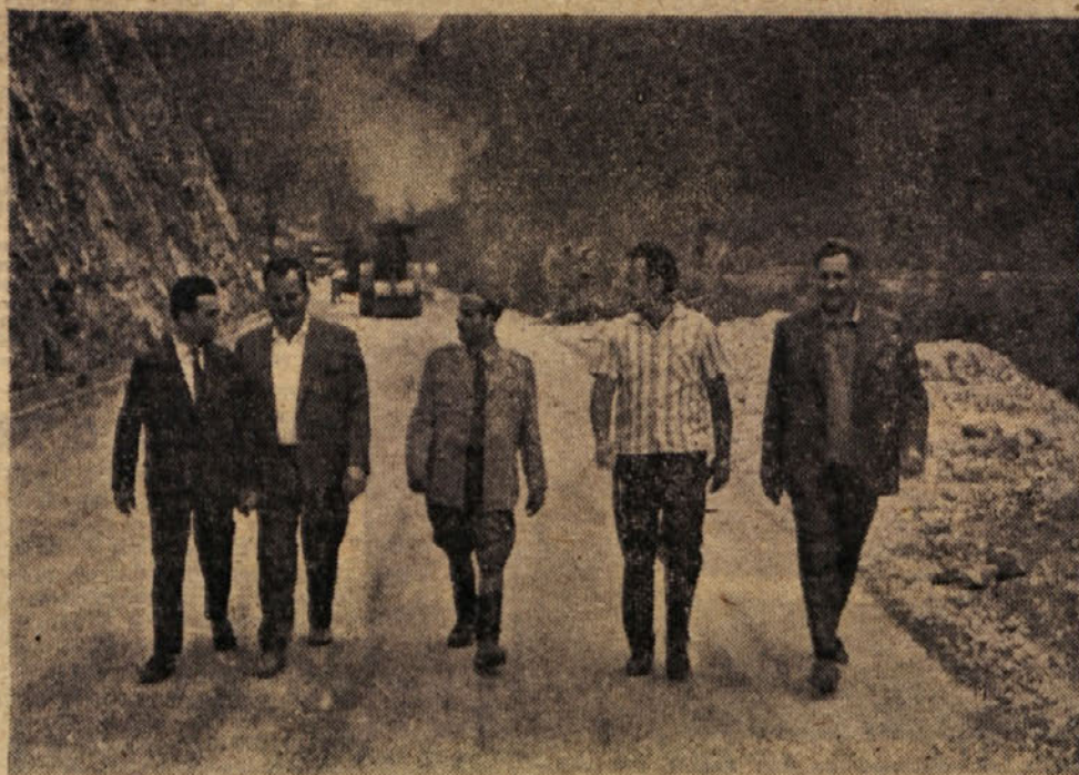
Gostje na odseku Zasavske ceste, ki je že skoraj narejen za asfaltiranje
