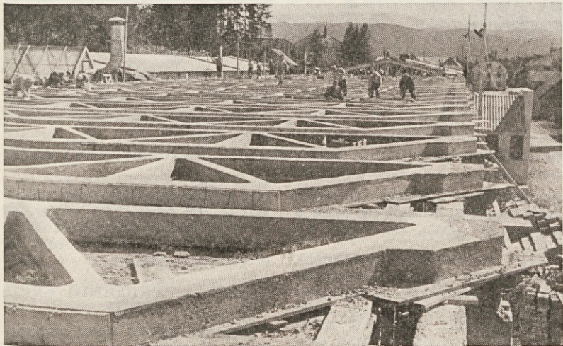
Obnova glavne hale v TP Cerknica po požaru
