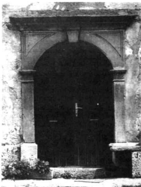
1. Polkrožni rožanci iz spodnjetriasnega apnenca s segmentnim lokom, sklepnikom, trikotnima poljema na vsaki strani, ki jo skupaj s sklepnikom pokriva profilirana nadportalna polica pri Kacinovi domačiji na Cerkljanskem Vrhu 1.
