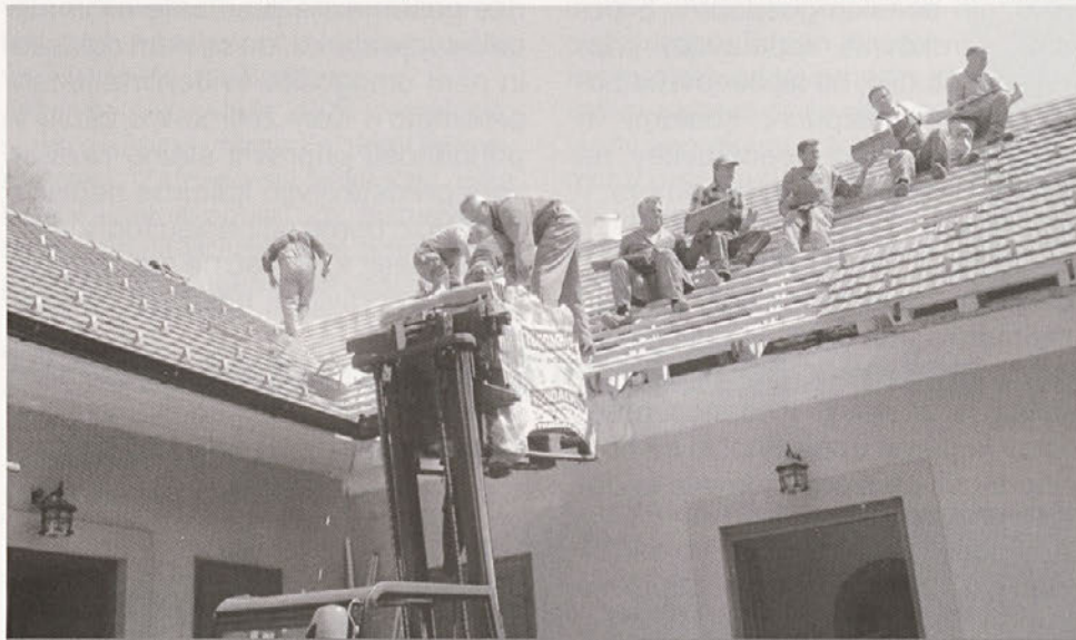
Prvomajski prazniki so bili za člane LD Cirkulane delovni. Na lovskem domu v Brezovcu so uredili novo streho.
