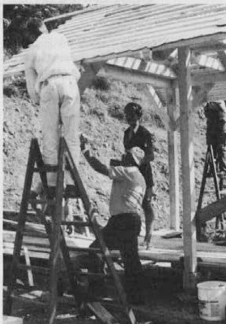
Med gradnjo čebelnjaka. Foto: M. Podjavoršek
