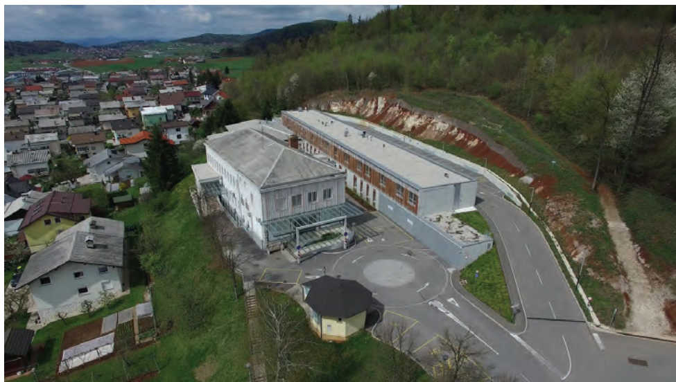
Energetsko saniran Zdravstveni dom Grosuplje.
