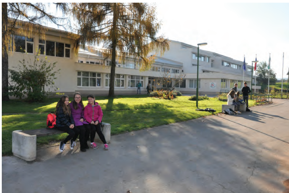
Energetsko sanirana Osnovna šola Louisa Adamiča Grosuplje.
