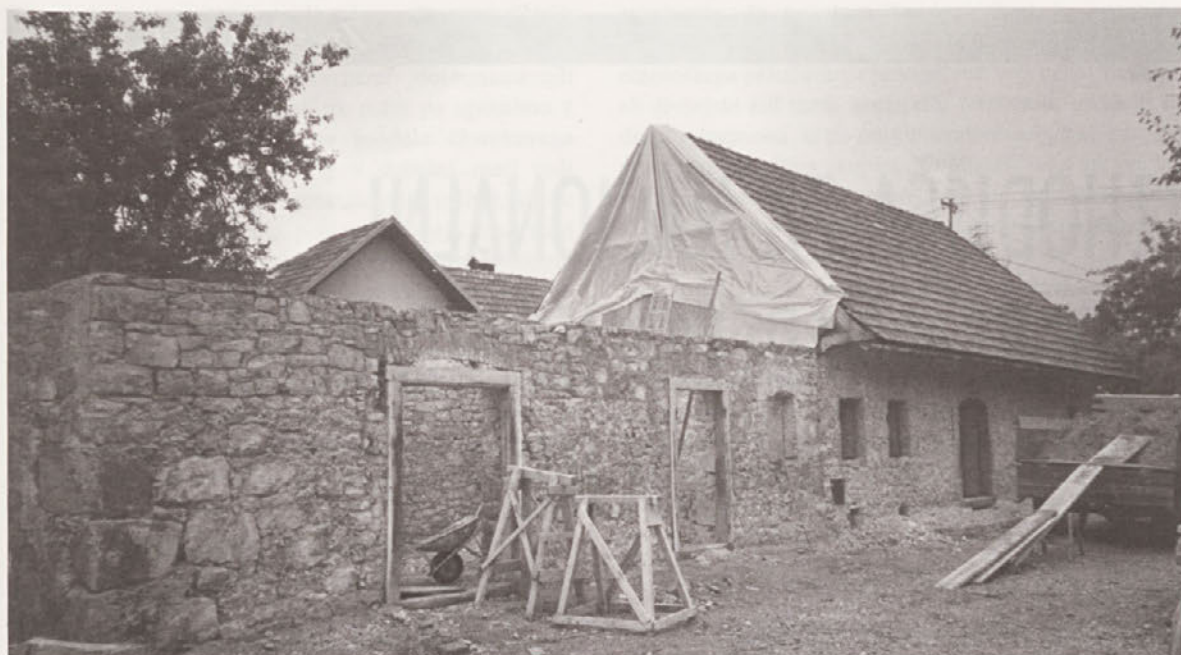
Hrovača 42, Škrabčeva hiša. Po slabem letu dni fizične obnove so 11. oktobra 1998 odprli za javnost prenovljeno Škrabčevo hišo. Njeno obnovo je v celoti financiral lastnik Janez Škrabec, znani slovenski poslovnež. Konservator-etnolog Hazler in arhitekt Rot sta imela pri svojem delu povsem proste roke. Njuna strokovna navodila so izvajalci del upoštevali v celoti. V muzejskem delu hiše je razstavljenih čez 600 predmetov, ki so jih prvi evidentirali študentje Oddelka za etnologijo in kulturno antropologijo FF v Ljubljani.
