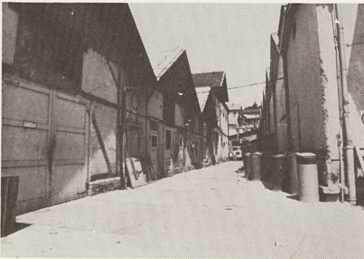
Pomožne delavnice so v starih zgradbah, ki kar izzivajo požar.
