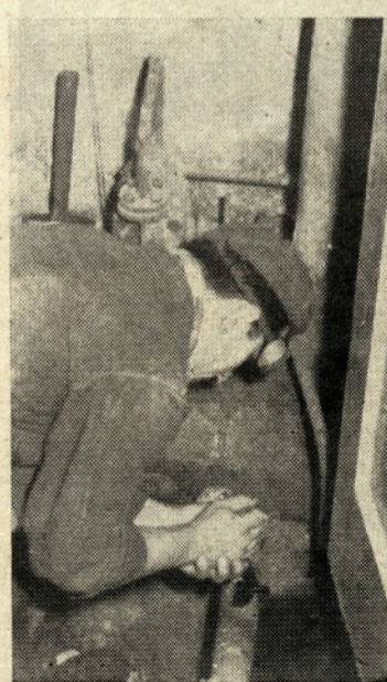
Delavec iz vzdrževalnih obratov varj počeno cev
