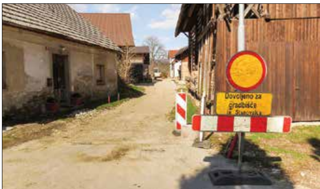
Na javni poti skozi vas Dobreline potekajo gradbena dela za napeljavo in prenovu vodovoda. (Foto: IS)
