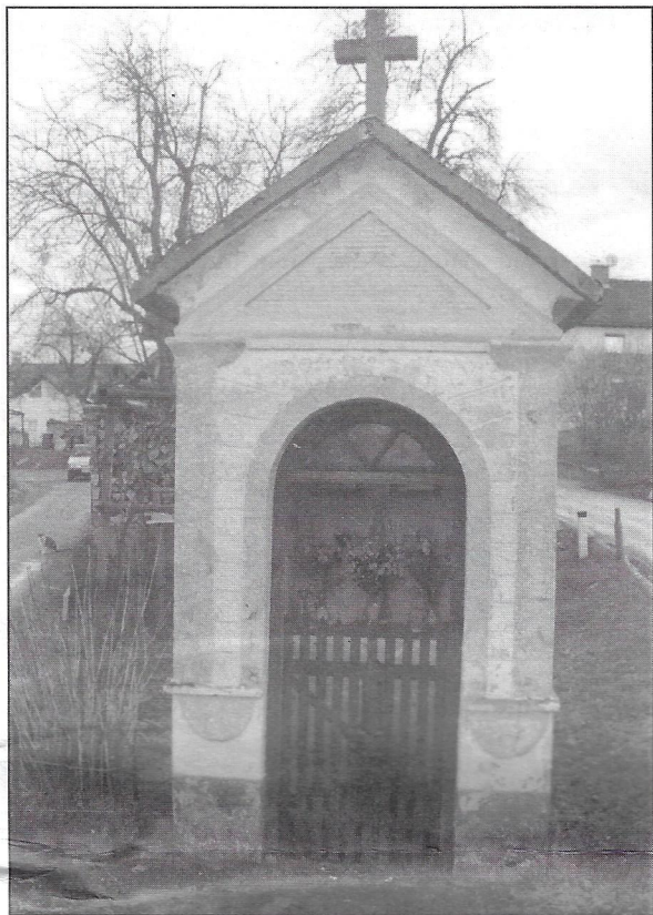
Zunanost kapelice, pogled s severne strani
