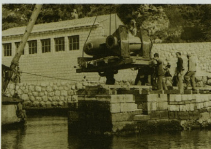
Strojna skupina pri razkladanju enega od turbinskih statorjev Peltonovih turbin. V ozadju del elektrarniškega poslopja za visokonapetostno postrojenje.
