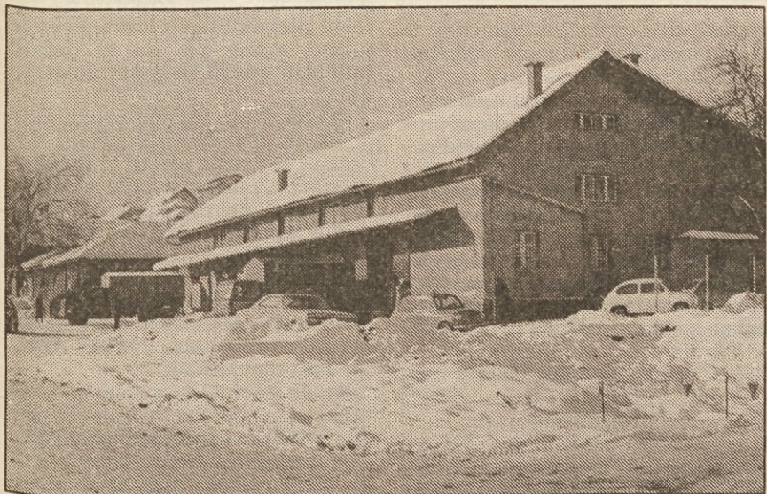
Malo naprej od nove Blagovnice, ki bo dokončana letos, je staro, premajhno in neprimerno skladišče. V letih 1983/84 naj bi začeli graditi prvo etapo novega.
