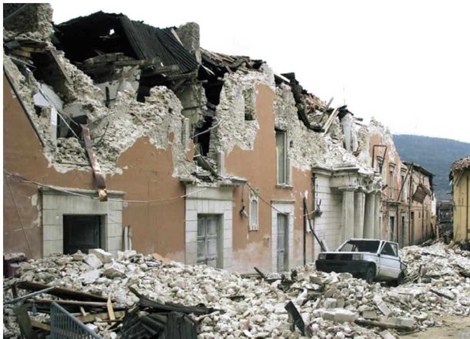
Slika 1 • L'Aquila, april 2009: po potresu prizadete stavbe (foto P. Weiss)
