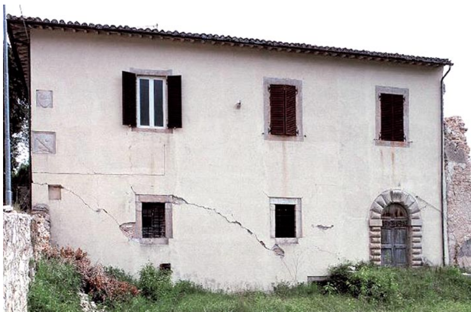
Slika 5 • Umbrija, 1997: tipične strižne razpoke v kamnitem zidovju
