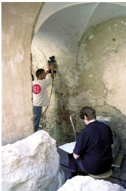
Slika 7 • Ugotavljanje homogenosti kamnitega zidovja z radarjem (arhiv ZAG, foto V. Bosiljkov)
