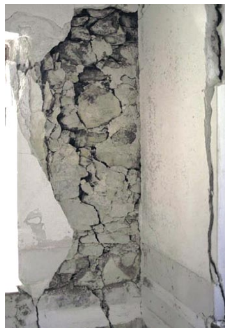
Slika 6 • Posočje, 1998: razslojevanje kamnitega zidovja
