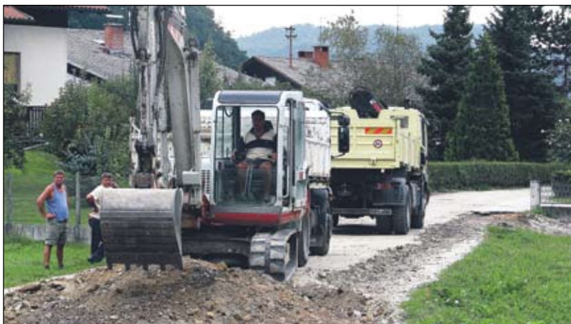
Zaključna dela pri gradnji kanalizacije na Prelogu
