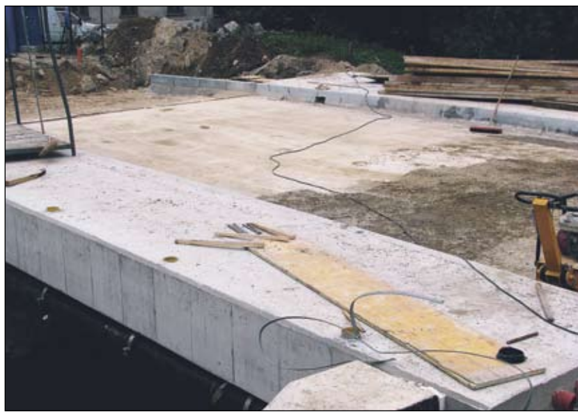
Zaključna dela na mostu Dragomelj
