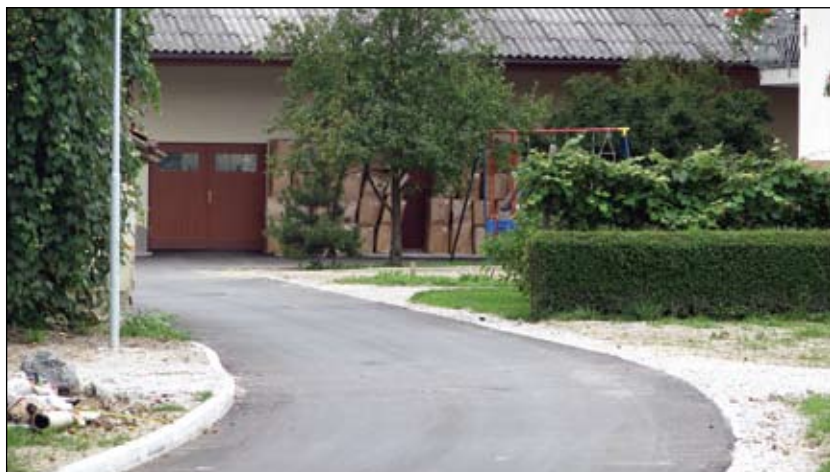
Rekonstrukcija Kovaške ceste z vgrajenimi komunalnimi vodi in javno razsvetljavo
