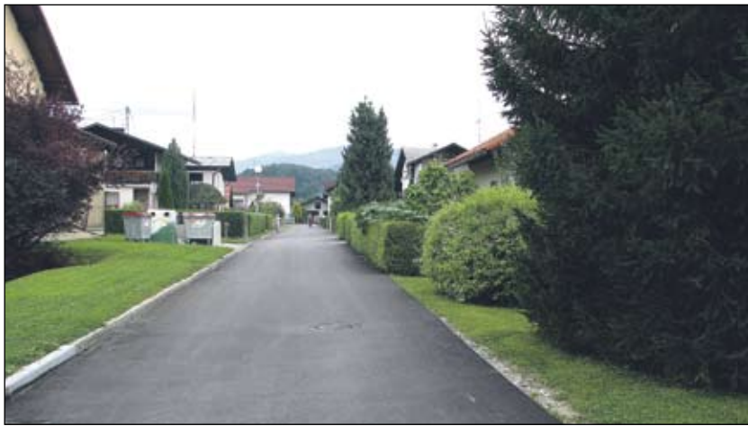
Po zaključku projekta plinifikacije je bila obnovljena Triglavska ulica
