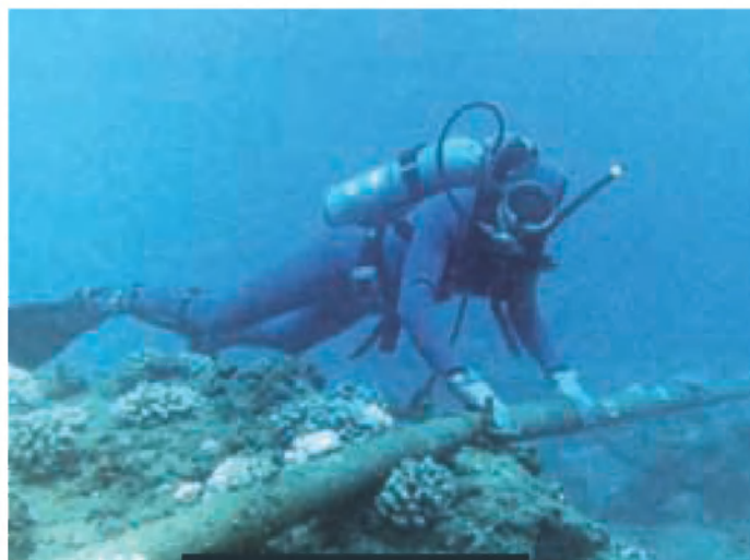
Potapljač pregleduje optični kabel v plitvem morju.
