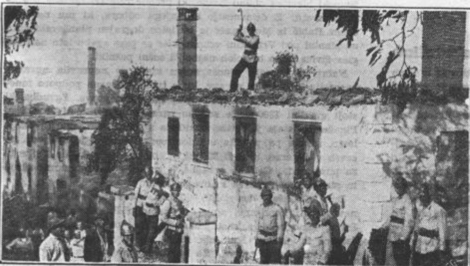
Gasilci razkopavajo ruševine gostilne na Köstnerjevem posestvu, kjer je izbruhnil požar
