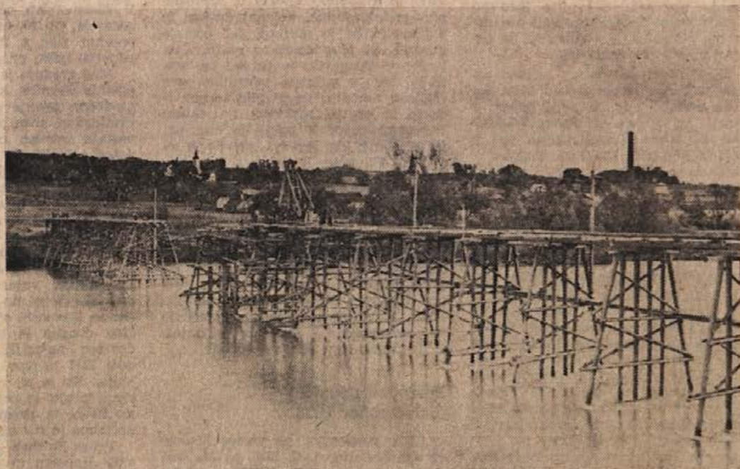
Pogled na pomožni most pri gradnji železniškega mosta čez Savo v Sevnici (Foto: Živković, 30. oktobra 1937, last B. Milosta)
