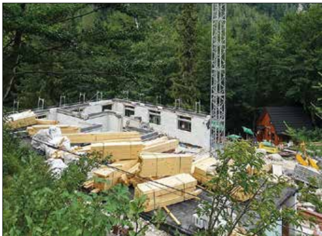
Gradbena dela na mestu starega Frischaufovega doma.
