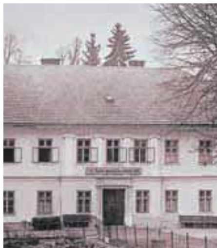
Stavba nekdanje gasilske šole v Medvodah.
