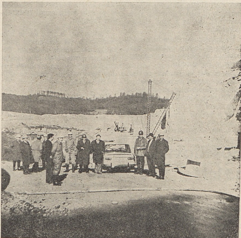
Udeleženci ekskurzije podružnice ZGRMIT pri ZPT, dne 5. 2. 1974, na gradbišču TOZD RGD v Podsusedu. Posnetek je bil narejen v kamnolomu. (Foto inž. M. Mlakar)
