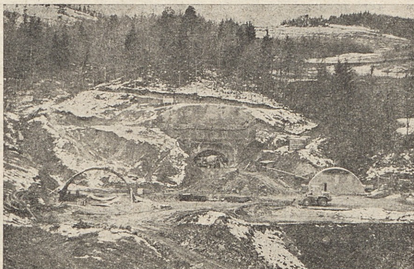
TOZD Rudarska gradbena dejavnost, je pričela na gradbišču avto ceste Hoče-Levec, z izgradnjo predora Pletovarje. Posnetek je bil napravljen januarja 1974 (Foto inž. C. Majdič)
