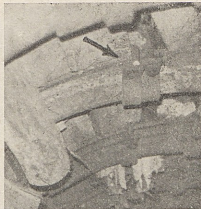
Slika 3 Zaradi velikih napetosti v objemki, je odletela matica. (Foto J. Kirič)
