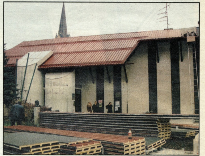
Obnova strehe Kulturnega doma Vransko
