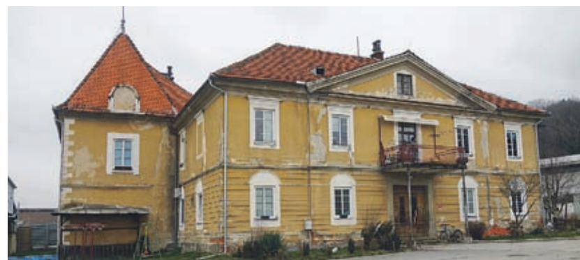
Še v prvi polovici tega leta bodo na objektu Baronija stekla večja vzdrževalno-obnovitvena dela.
