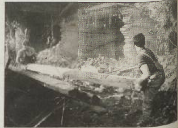
PODRLI KUČANOVO DELAVNICO - Po dolgotrajnih prizadevanjih je znana Kučanova delavnica sredi Murske Sobote, ki je zaradi zapuščenosti postala prava soboška sramota, popeljala. Še prej pa so iz nje v rakičanski grad odpeljali stroje in opremo, ki predstavljajo pomembno kulturno in zgodovinsko dediščino. V rakičanskem gradu bodo uredili tehniški muzej. Besedilo: M. JERŠE, fotografija: J. ZAUNEKER
