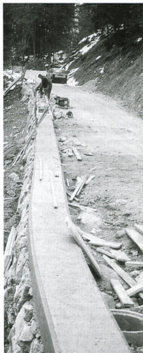
Trajna sanacija zemeljskega plazov na lokalni cesti Šmartno-Češnjice-Blagovica (Lipa)
