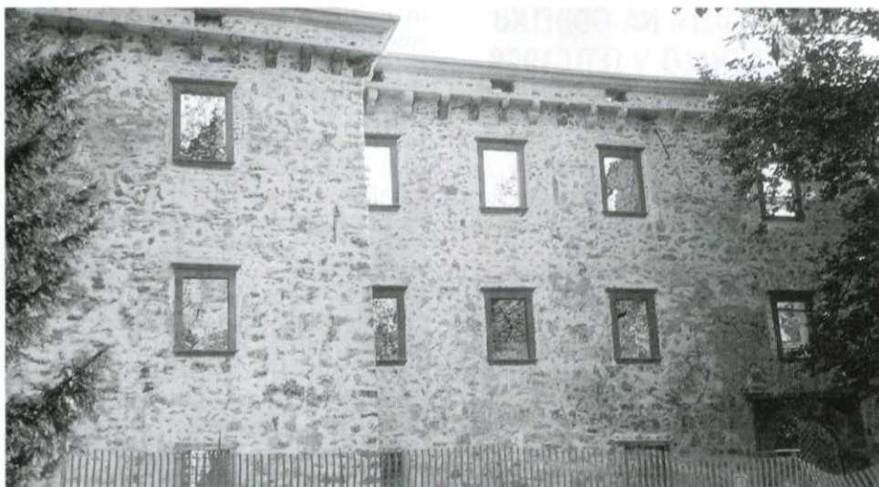
Grad Brdo - obnovljeno zahodno pročelje
