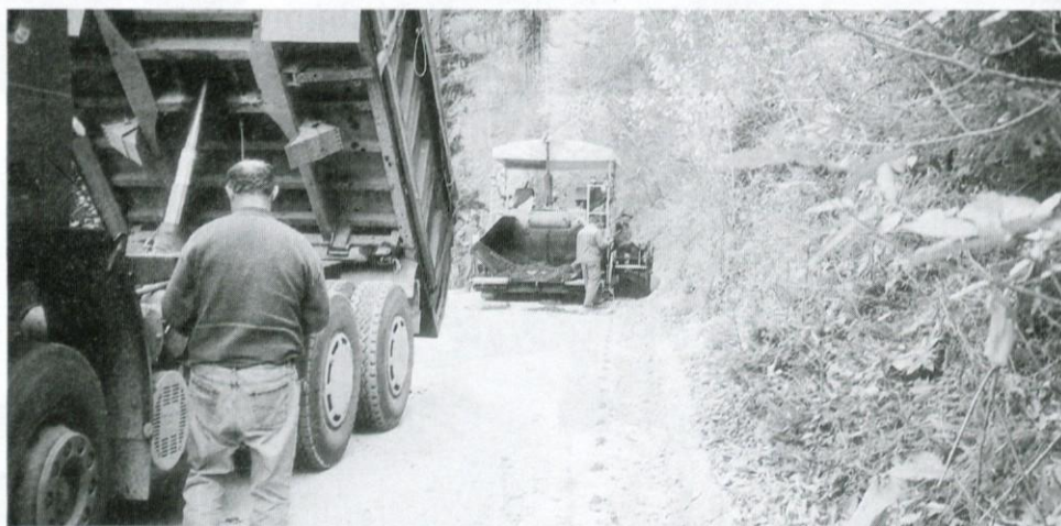
Rekonstrukcija ceste v Gorenje
