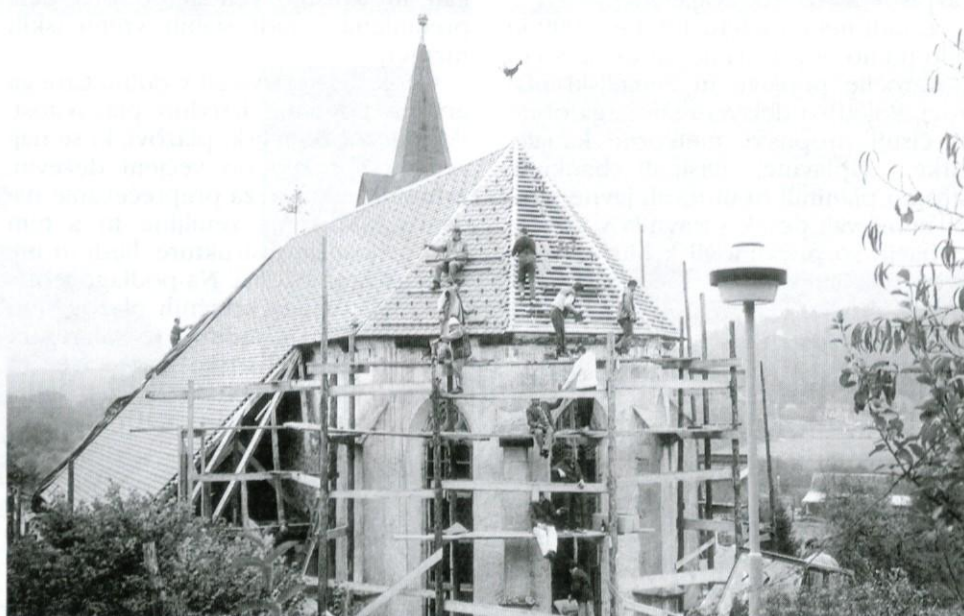
Obnova ostrešja na p. c. sv. Luka v Sp. Praprečah
