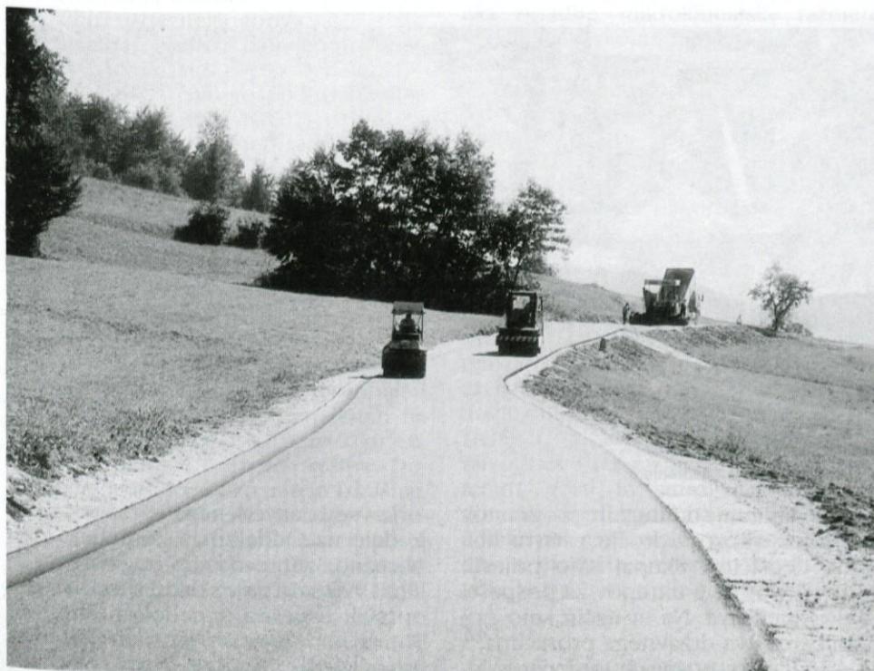
Rekonstrukcija ceste Bobovnik-Imenje
