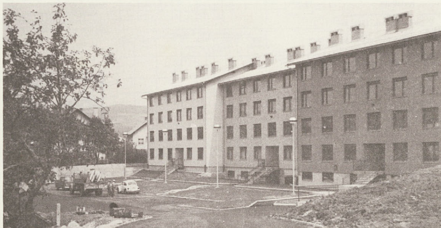
Samski dom, ki bo na tekmovalni dan, 12. septembra 1981, svečano odprt (foto: Borsan).
